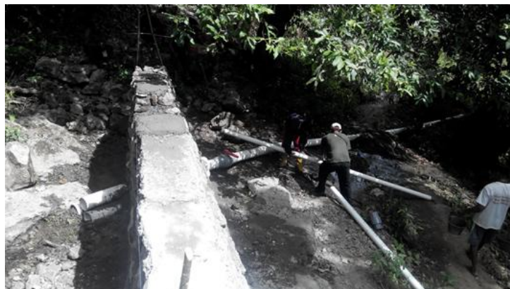
Gambar 5. Bangunan bendung sadap untuk menampung mata air Matajang di Bukit Matajang
