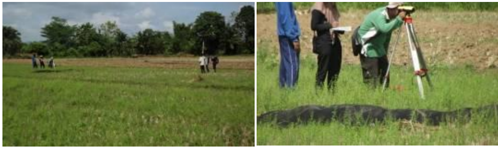
Gambar 19. Pengukuran beda tinggi dengan waterpass untuk penentuan saluran dan bak bagi
